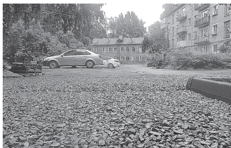
Двор на Парковой, 13 подготовлен к асфальтированию: уложен новый бордюр и щебневая «подушка»
